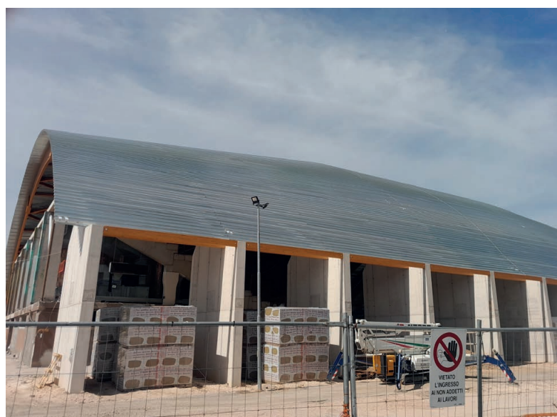
Lavori in corso al PalaGuerrieri di Fabriano
